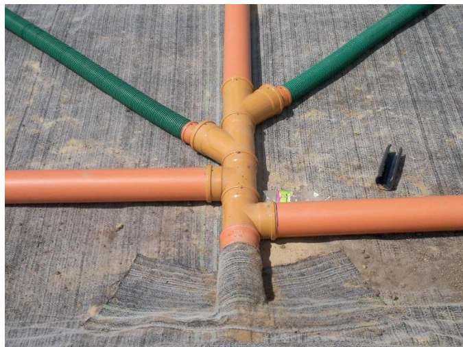
Rysunek 8. Wyprowadzenie drenażu zbierającego przez matę bentonitową
