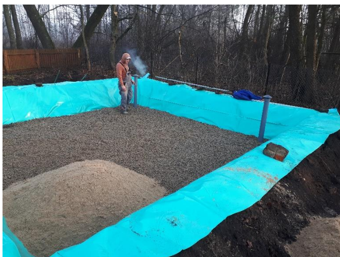
Rysunek 10. Usypanie warstwy piasku
