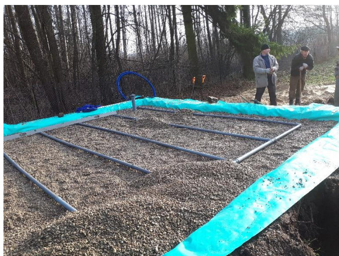
Rysunek 12. Drenaż rozsączający w obsypce
