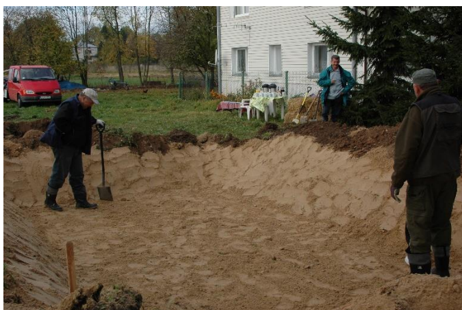
Rysunek 4. Wykonanie pierwszej warstwy filtra – piasku pod folię.
