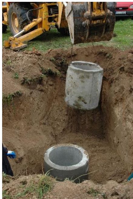
Rysunek 3. Montaż studni chłonnej
