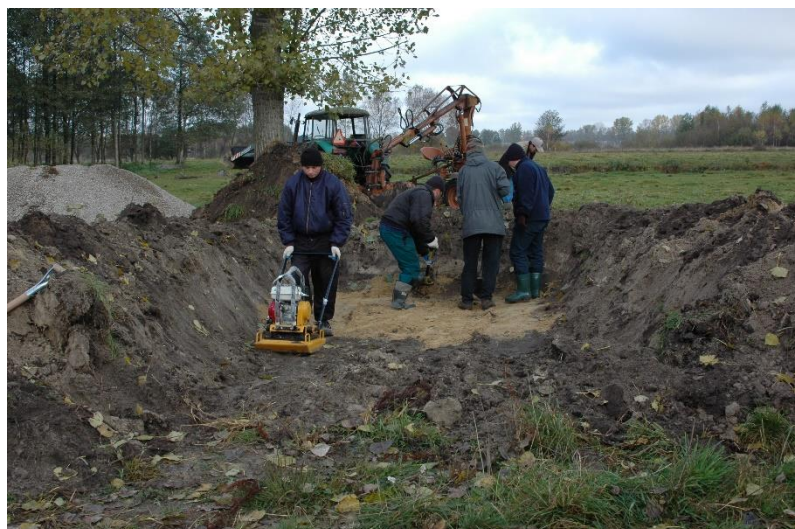
Rysunek 6. Profilowanie dna wykopu
