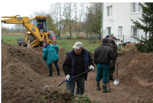
Rysunek 2. Wykop pod filtr piaskowy
