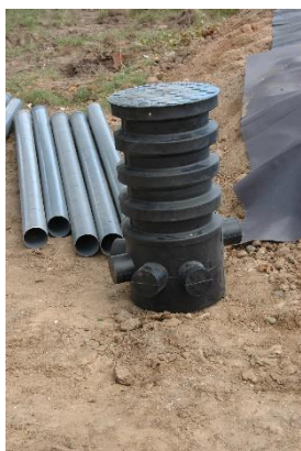
a) schemat studzienki w kształcie prostopadłościanu, b) zdjęcie studzienki w kształcie walca
