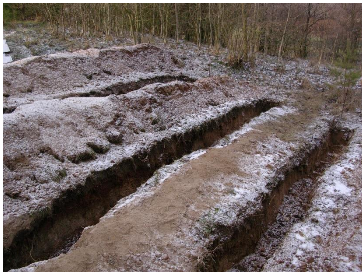
Rysunek 4. Wykop mechaniczny pod drenaż
