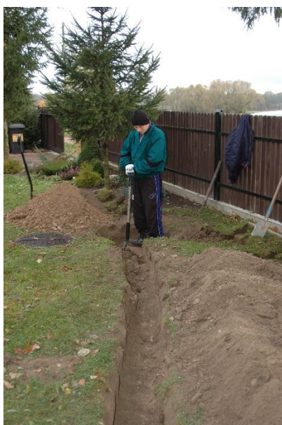
Rysunek 3. Wykop ręczny pod rury
