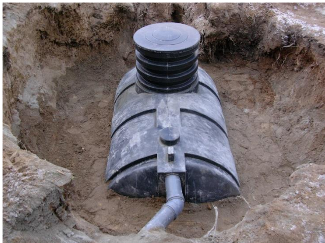
Rysunek 1. Montaż osadnika gnilnego
