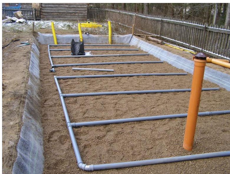
Rysunek 11. Układanie drenażu rozsączającego
