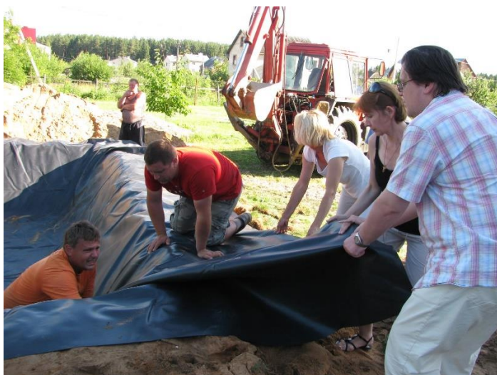
Rysunek 5. Rozściąganie drugiej warstwy filtra - folii
