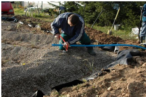
Rysunek 3. Połączenie osadnika z drenażem rozsączającym
