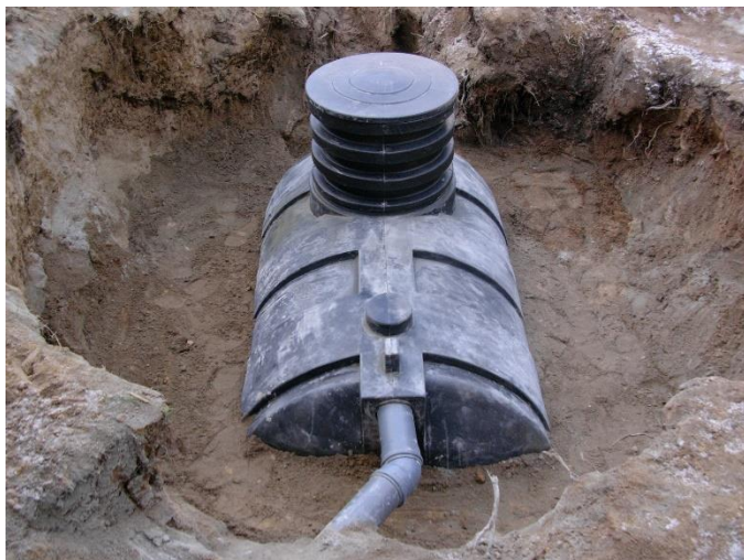
Rysunek 1. Montaż osadnika gnilnego
