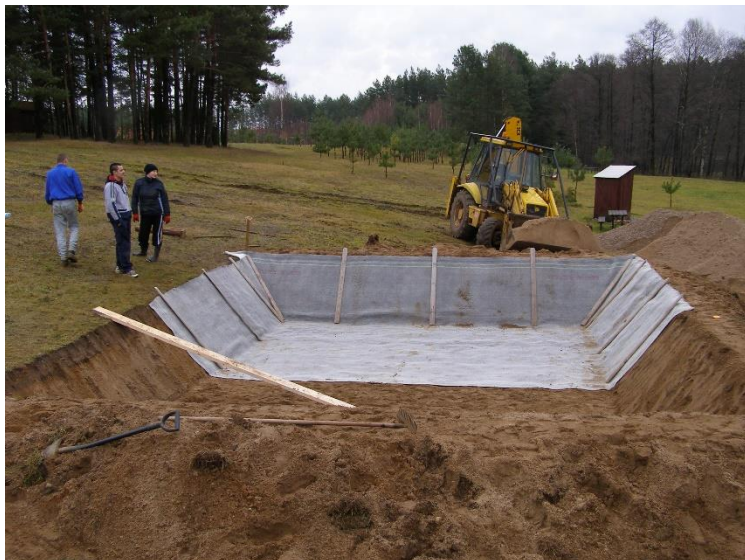
Rysunek 6. Wykonanie drugiej warstwy filtra – mata bentonitowa.
