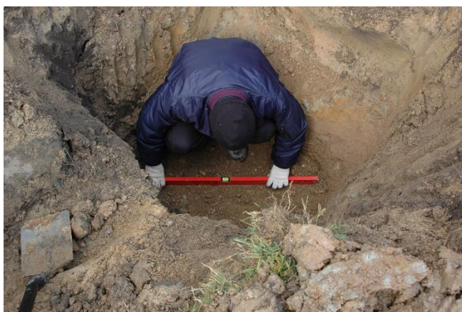
Rysunek 5. Poziomowanie dna wykopu
