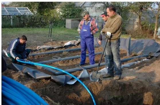
Rysunek 3. Połączenie osadnika z drenażem rozsączającym
