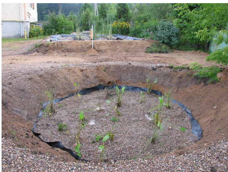
Rysunek 14. Wykonywanie oczka wodnego
